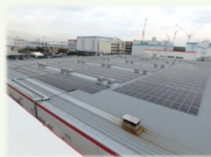
太陽光パネルの設置
